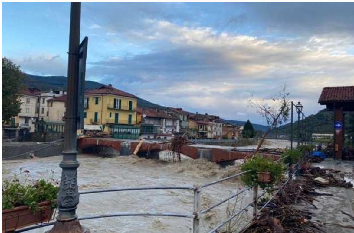
Ponte di Garessio (CN) sul fiume Tanaro
