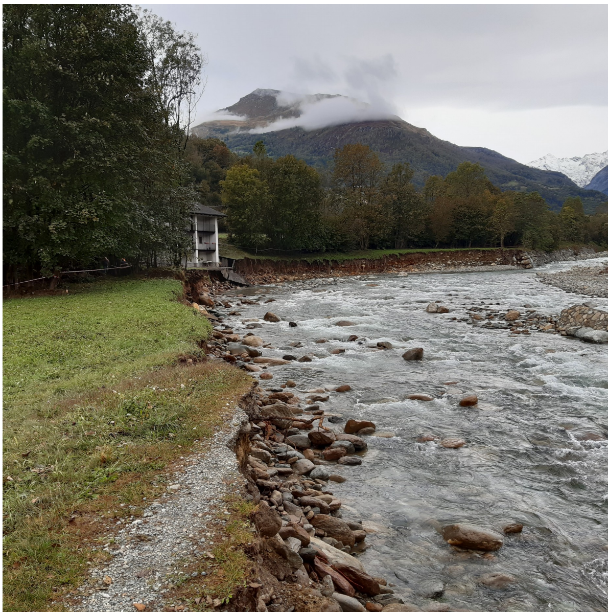
Figura 2. Erosione spondale torrente Chiusella
